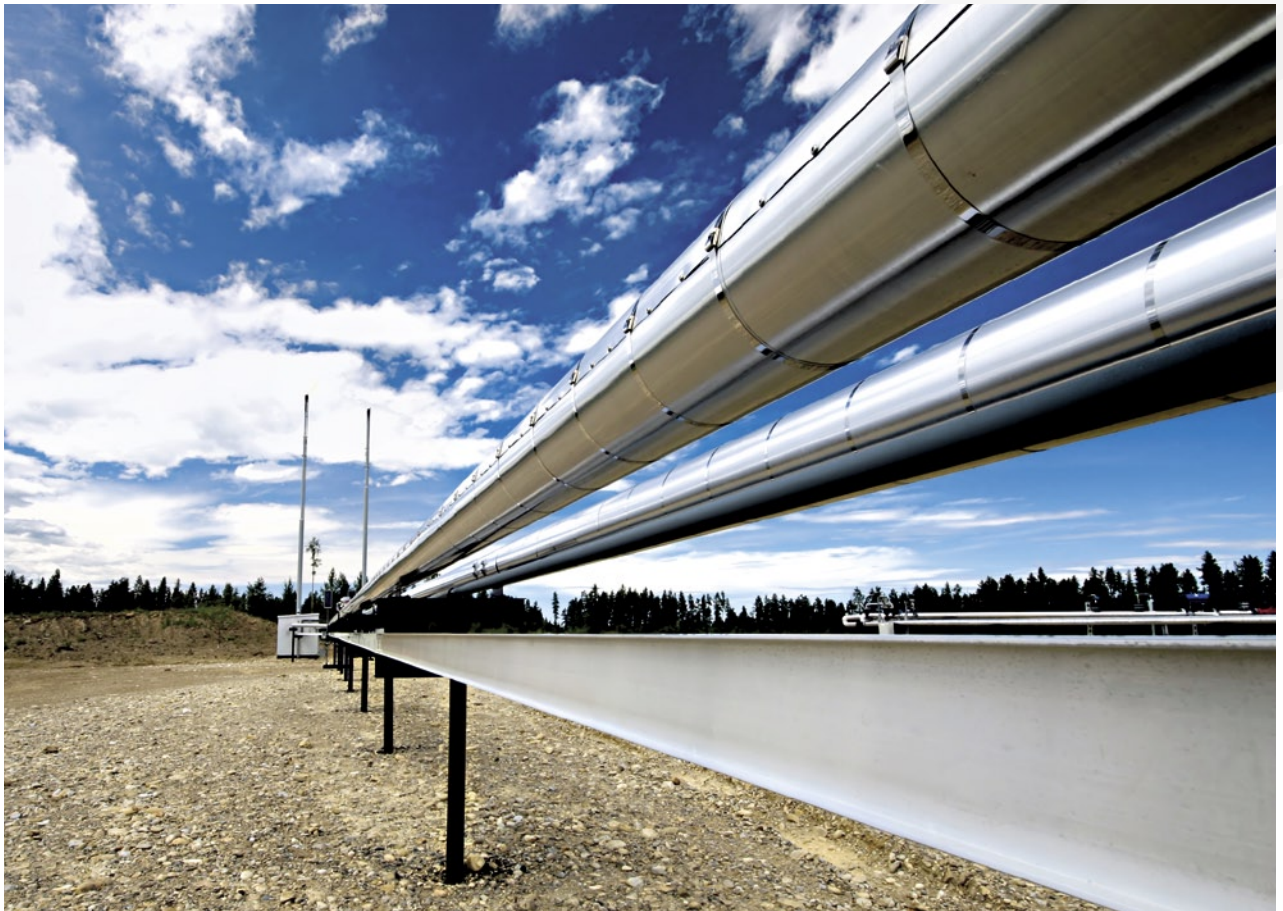
Pipeline: Steigende Nachfrage nach Öl und Gas hält die Preise hoch
